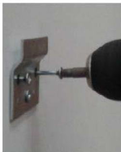
Una vez que el tornillo ha sido introducido hasta el tope, se sigue girando lentamente para contraer el tornillo hasta la placa y obtener el ajuste óptimo.
